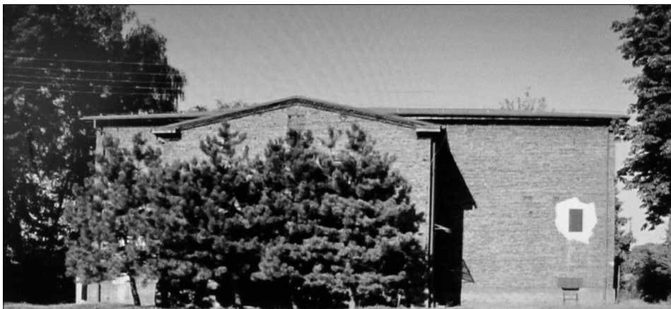
Fragment Budynku Parafialnego, w którym utworzono obóz przejściowy dla Polaków – Polenlager Nr 58 w Pszowie.
