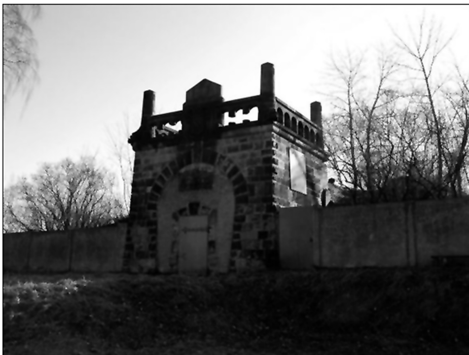
Widok wieży wodnej (ciśnień) w Rybniku.
